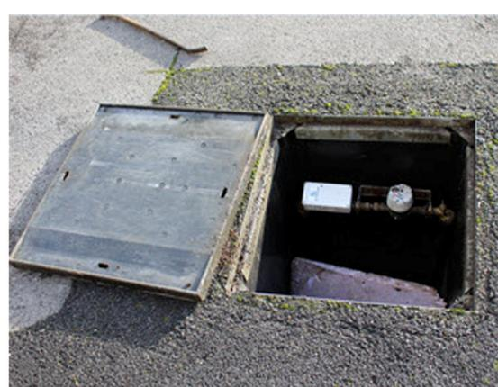
La vanne de purge wireless peut être installée dans un regard sous la voirie sans nécessiter d'alimentation locale
